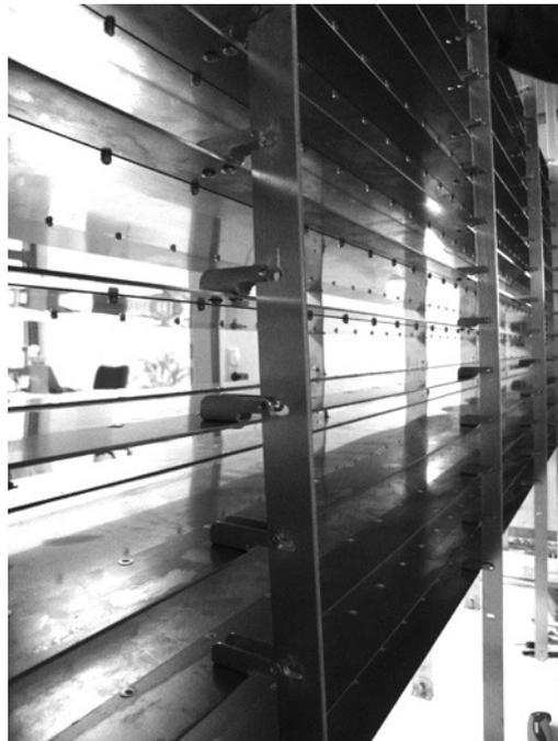
**Abbildung 45: Jalousie-Biegebleche und Verbindung zu den Zugstangen**
